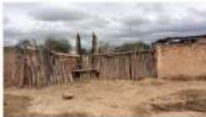
Viviendas precarias del norte de Salta
